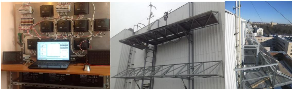
Рис.1. Внешний вид установки из помещения и с крыши, на верхней консоли расположены 5 солнечных модулей и установлена метеостанция.
