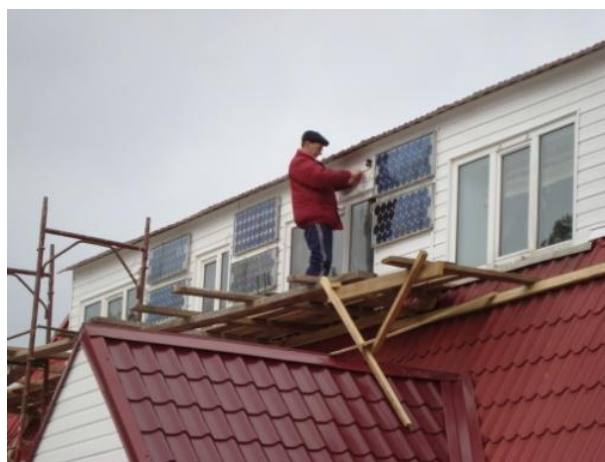
Рис.5. Монтаж ФЭП с вертикальным расположением на объекте «Энергоэффективный дом»
