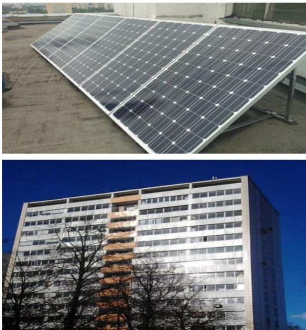
Рис.3 Солнечная энергоустановка на крыше МКД в одном из районов г. Москва
