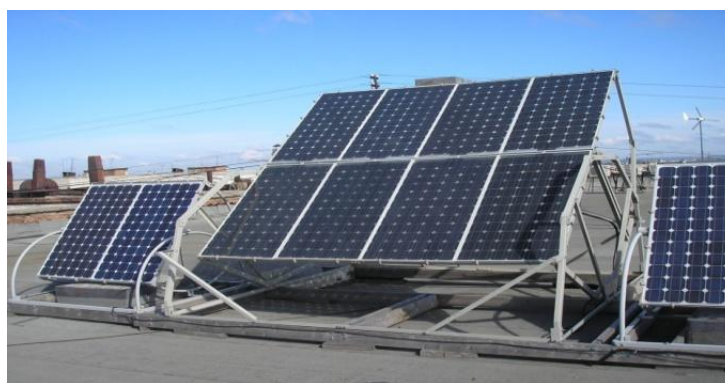
Рис. 1. Солнечно-ветровая электростанция мощностью 3 кВт ОАО НИИПП г. Томск.
